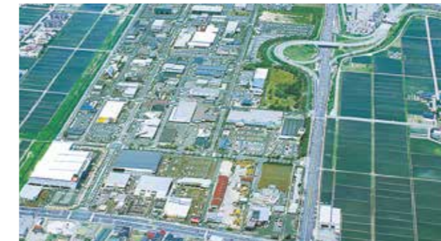
高度化資金で造成された会津若松卸商団地協同組合
