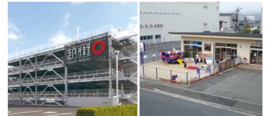
協同組合広島総合卸センターの立体駐車場
